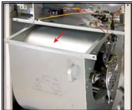
Slide-out fan for easy maintenance
